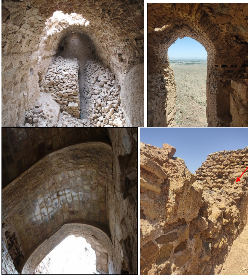
تصاویر ۱۹، ۲۰، ۲۱ و ۲۲: اجرای قوس جناقی و اجرکاری خفته راسته در درگاه غربی شاه نشین. نحوه اجرای طاق بیز (گهواره‌ای) در فضاهای زیرین شاه‌نشین. پایه تویزه باقی مانده دریکی از فضاهای زیرین شاه نشین. اجرای طاق و چشمه و طاق لاپوش اتاقک واقع در راه پله شمالی (عکس از نگارندگان)
