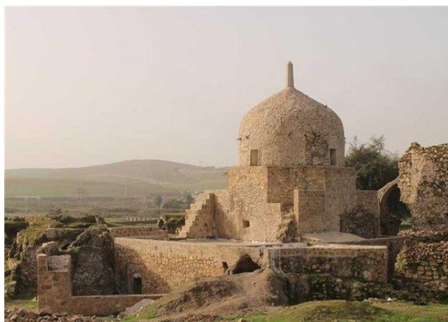
نمایی از بنای کهن امامزاده حمزه دهدشت (تندرو، خزایی و احمدپناه، همان: ص ۱۱۷)
