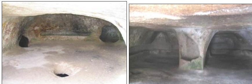
شکل ۷: (راست) نمونه‌ای از آغل‌های عمومی و بزرگ موجود در روستای حیلهور؛ (چپ) نمونه‌ای از آغل دوطبقه در روستای حیلهور. سوراخ‌های کف روزن طبقه پایین است.
